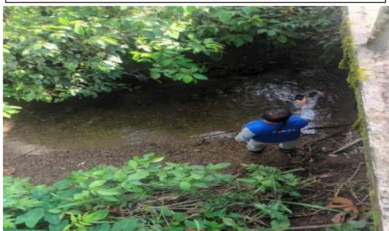
FIGURA N°03: SE OBSERVA LA SECCIÓN HIDRAULICA DE LA QUEBRADA PACHACUTEC DISMINUIDO POR LA COLMATACIÓN DEL MATERIAL DE ARRASTRE, AFECTANDO EL ESTRIBO DEL PUENTE
